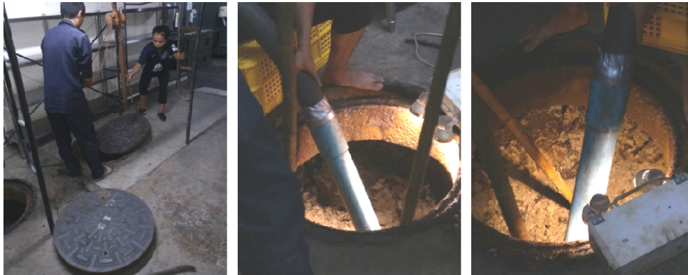
ภาพที่ 4-7 การสูบน้ำมันออกจากบ่อตกไขมันทุก 3 เดือน
